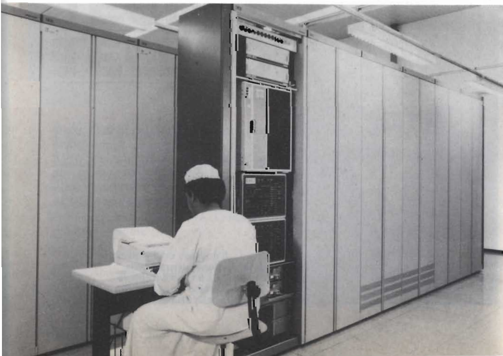
Fig. 4 - Il sultano di Oman è uno dei 18 paesi che ha adottato il sistema digitale di commutazione telefonica EWSD della Siemens alla qbrah ha ordinato 5 milioni di unità di linea. La foto mostra un sistema che prevede l'allacciamento con 17.000 utenti. È entrato in servizio nel Novembre del 1984.
